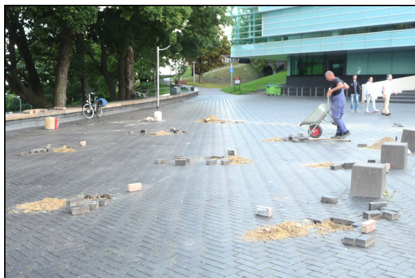
Fig. 10. De bronzen klinkers worden op de goede plek met cement vastgelegd.
