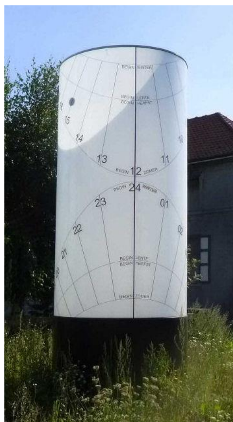
Fig. 2. De cilinderzonnewijzer in Humbeek. Het bovenste lijnenstel is de eigenlijke zonnewijzer, op het patroon daaronder wordt 's nachts door een projector een lichtvlek geworpen. Bron: www.wijzerweb.be .
