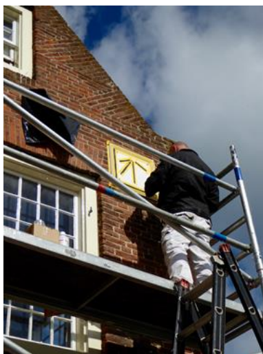
Uitvoering schilderwerk en het bevestigen van de poolstijl
